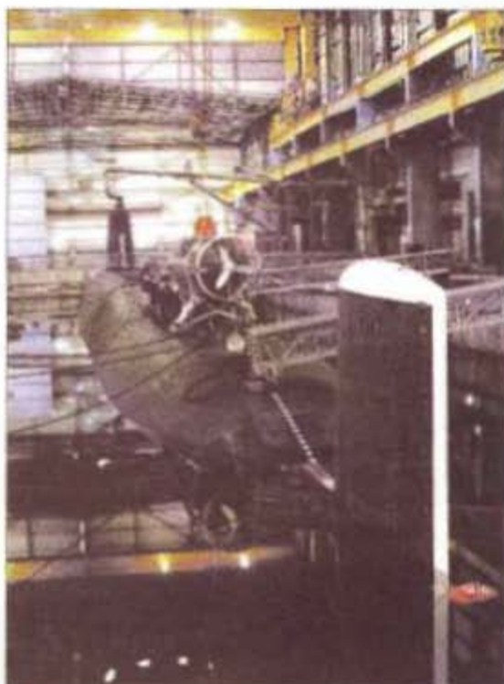
Работы по строительству ПЛАРБ типа «Визгард»
